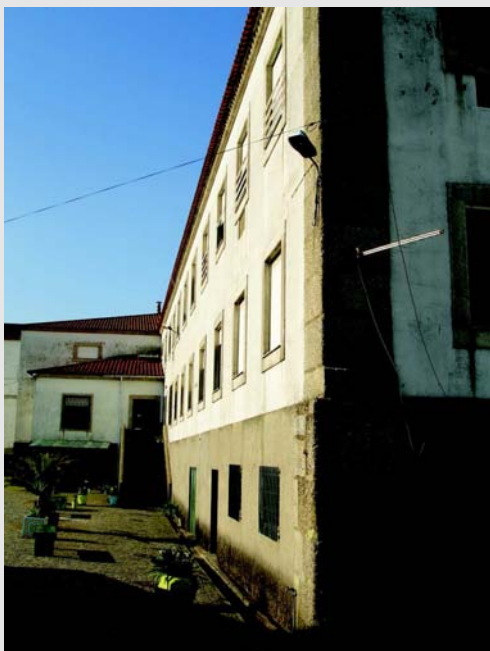
Fachada da EP CISAVE
